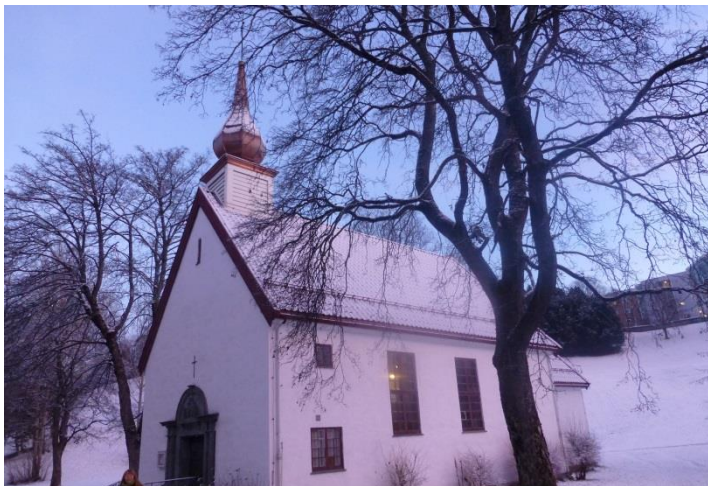
Trondheim Døvekirke fikk restaurert tårnet i 2013
