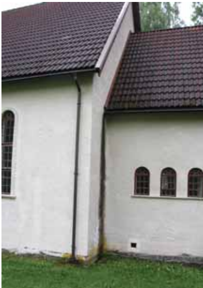
Gulsrud kirke: Nye takrenner og reparasjon av vegg der vannet har rent «feil sted».
