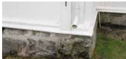
Vestre Spone kirke: Denne og flere av de andre kirkene får forlengede takrenner og nymalte vannbrett
