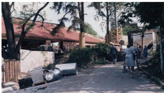
Byggeplassen for 30 år siden
