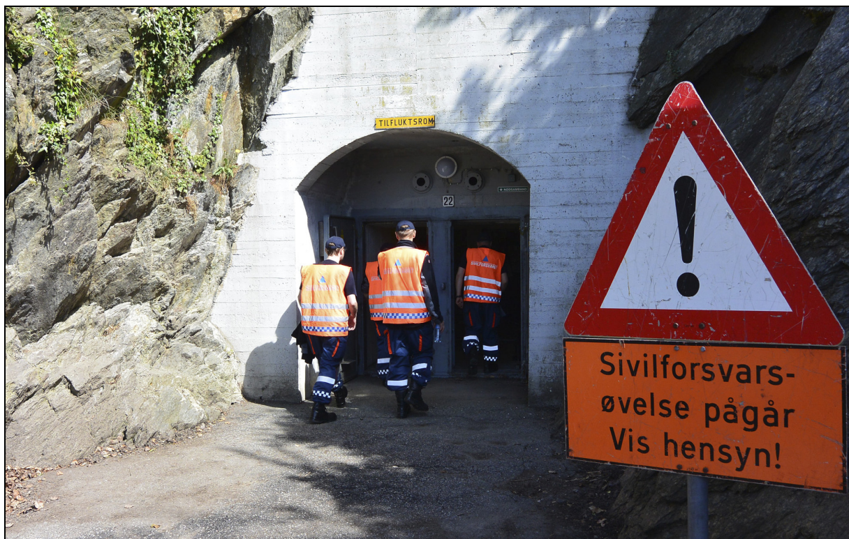
Figur 11.1 Sivilforsvaret fører tilsyn med tilfluktsrom.
