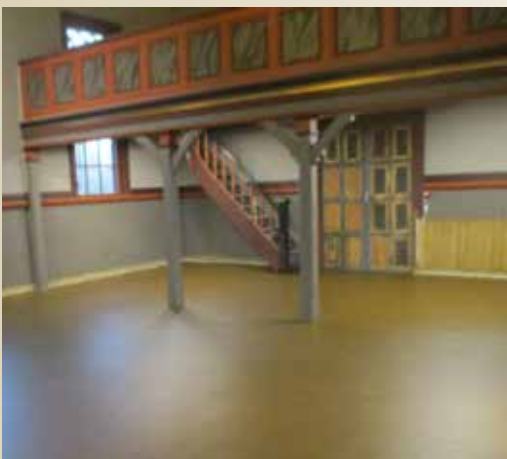
Nytt golv er lagt, pusset og malt i originalfargen.
