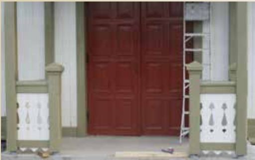
Inngangspartiet tar form.
