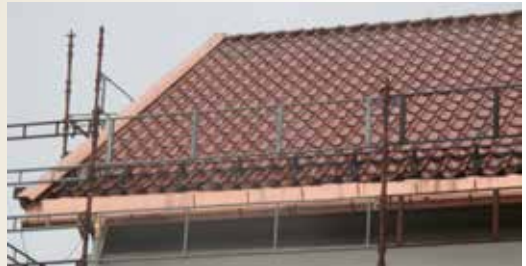
Nytt kobber i takrenner og på isbord.
