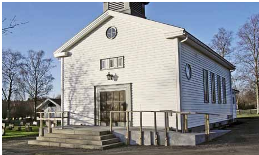
Mysen kapell har fått rullestolrampe. Et pent rekkverk og HC - toalett kommer etter hvert.
