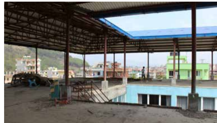
3. etasje, hvor det bygges samlingshall og gymsal.
