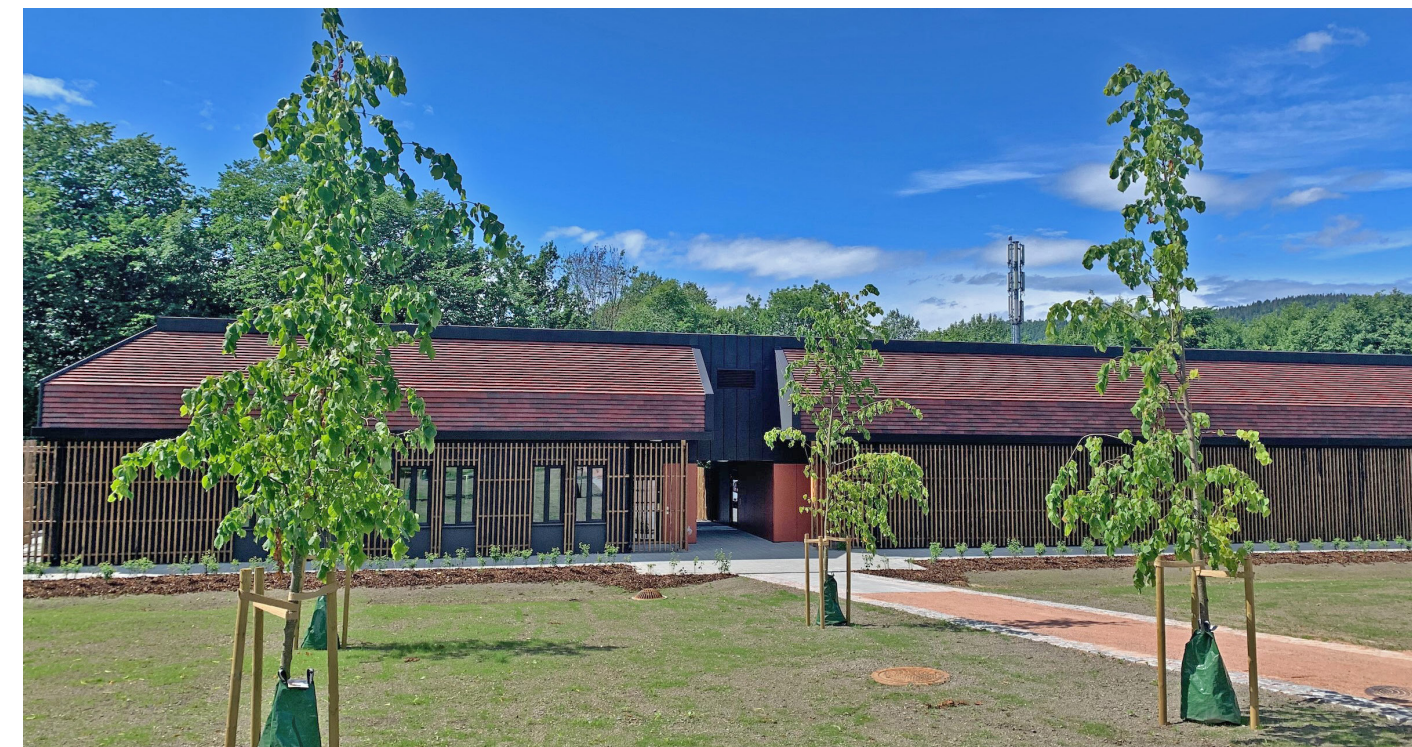
Det nye driftsbygget (Foto: Merete Fossli)
