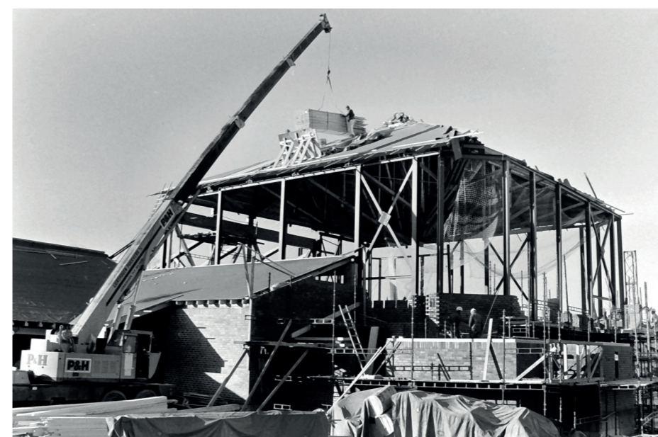
Den imponerende takkonstruksjonen er i ferd med å komme på plass.
