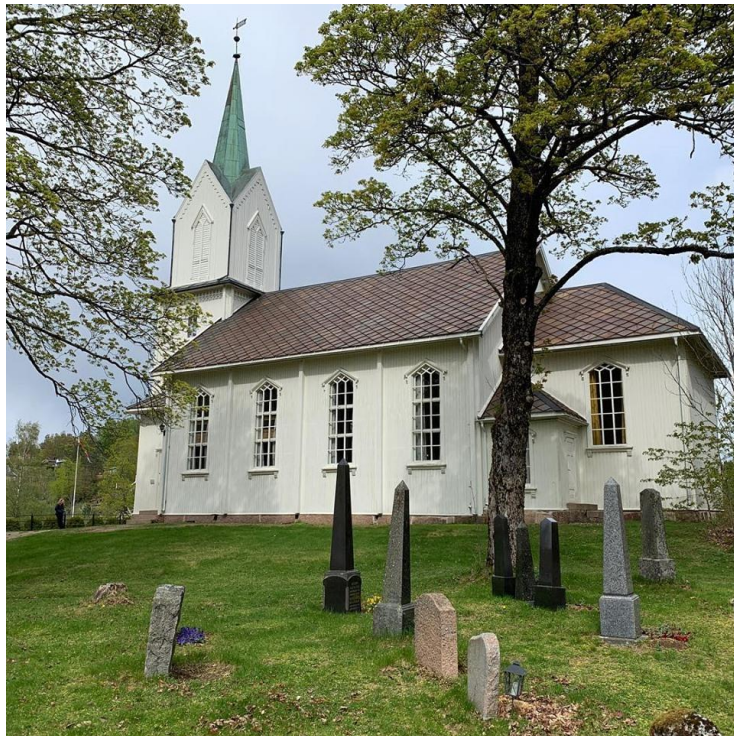
Holmsbu kirke (foto Øyvind Woie)
