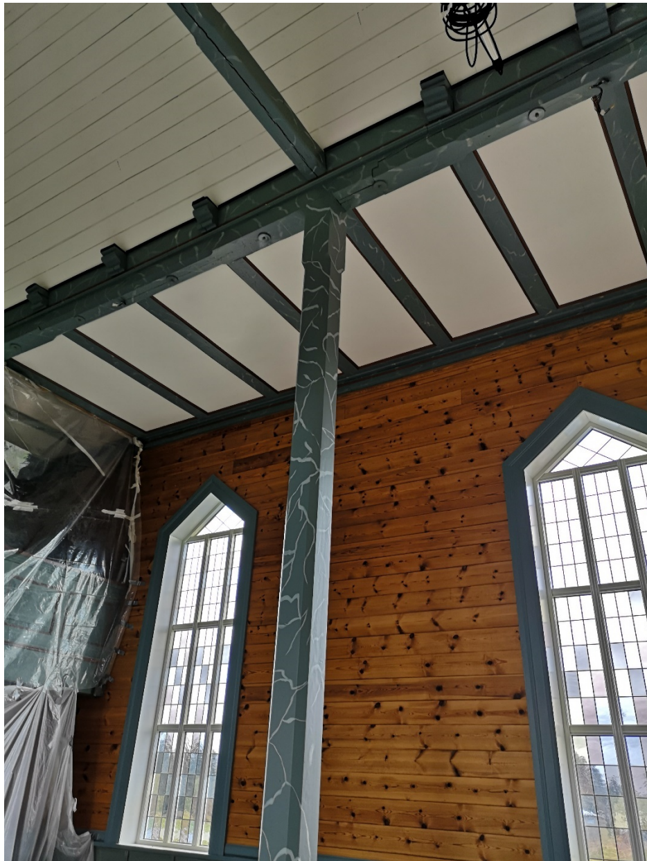
Ei av 4 nye søyler i kyrkja, plassert på nytt stødig fundament.
