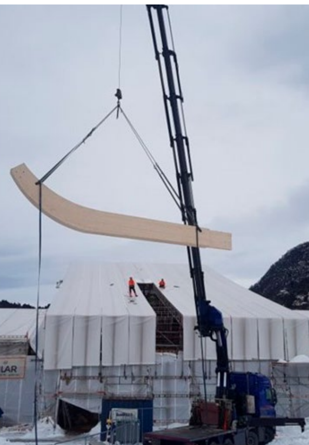
Fyllingsdalen: Ny drager heises på plass til kirketaket. Foto: BKF
