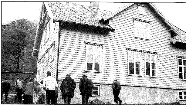
Soknerådet på synfaring i den nyrestaurerte prestegarden.
