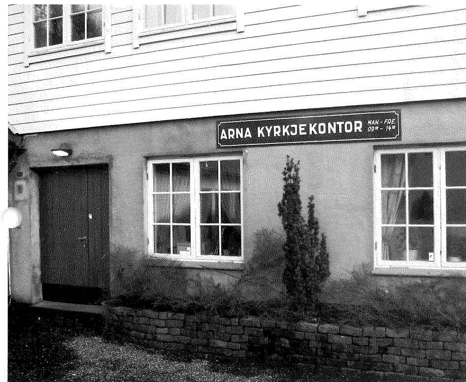
Inngangen til det nye kyrkjekontoret for Arna og Ytre Arna er frå parkeringsplassen på vestsiden av Kyrkjelydshuset i Indre Arna.
