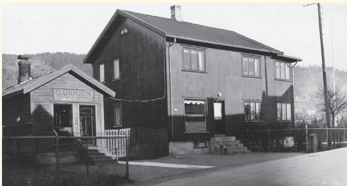
I Hotvetveien Vest 5 var det i mange år to frisører og en skomaker, Olaf Unhjem. I 1967 overtok Kjell Unhjem etter faren. Skomakeren holdt først til i et eget lite hus, som vi ser på bildet, men dette ble senere bygget sammen med bolighuset. (Kjell Unhjem)
