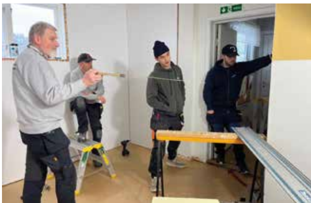
Snekkere og rørleggere diskuterer alternative løsninger for kjøkkeninnredningen på Flateby menighetshus.
