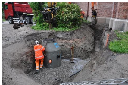
Nye kummer til avløp, spillvann, overvann og drenering
