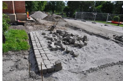
Resetting og gjenbruk av all storgatestein foran tårnet
