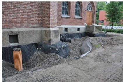
Nye kummer til avløp, spillvann, overvann og drenering
