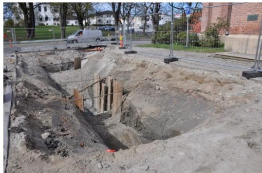
Avløpsgrøft –spillvann og overvann. Påkobling mot Riddervoldsgate.
