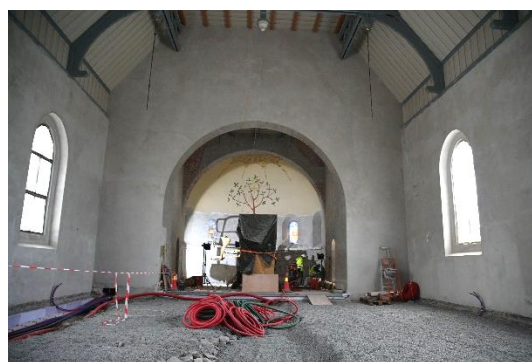
Ny oppbygging av kirkegulvet
