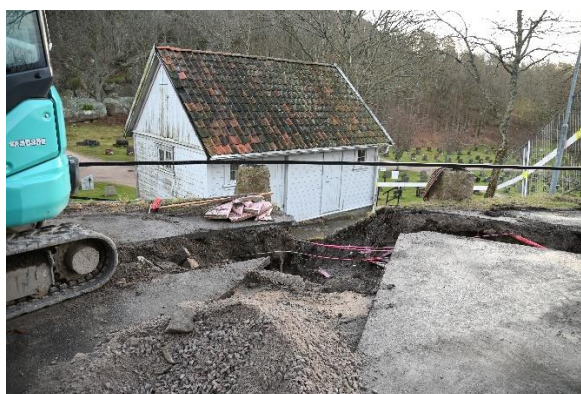
Det gamle uthuset før riving
