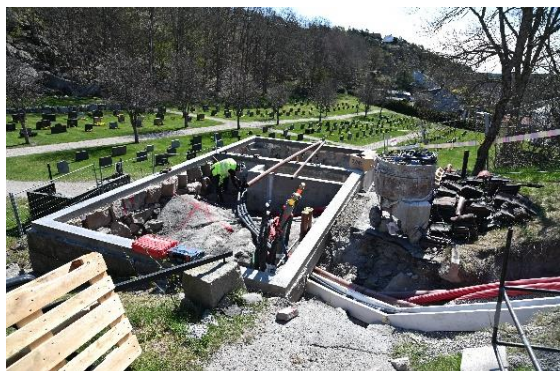
April 2020: Grøfter til energibrønner og varmeanlegg er lagt ned til uthuset, som skal bygges om til teknisk rom og lager.
