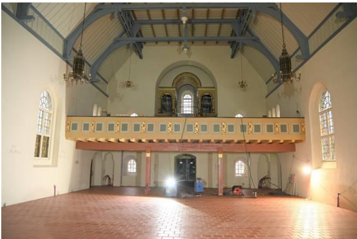
Kråkerøy kirke under rehab. 14. des. 2020 (foto HL)
