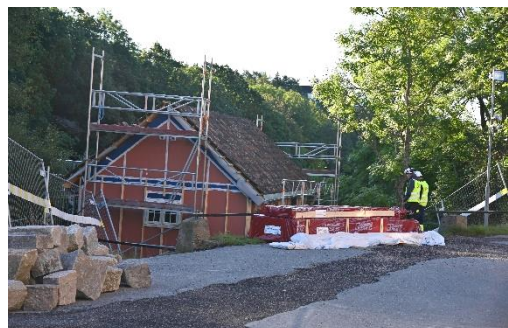
Nytt uthus ved kirken er under tak-foto 24.aug. 2020 For tekn. rom, varmesentral til kirken og lager.
