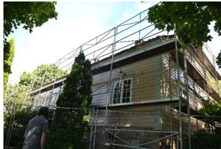
Kirkestua-foto 24. aug. 2020, pågår tak og fasaderehab.
