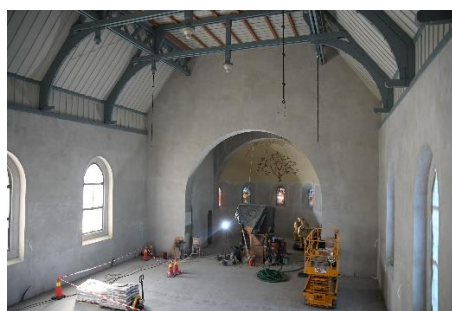
Foto 24.aug 2020. Rehab. av veggpuss pågår, Malerarbeider i tak pågår.
