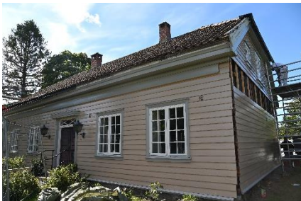
Kirkestua-foto 24.aug 2020 Rehab. av fasader pågår.
