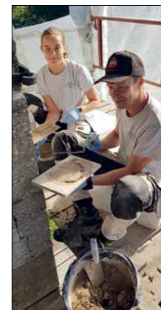
Nitidig arbeid med spekking av fuger med kalkmørtel på Nikolaikirken.
