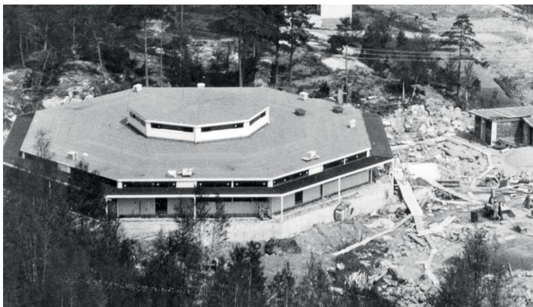
Åttekanten skole som nybygg.
