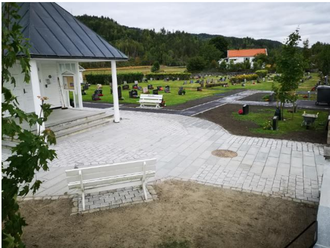
Kvelde kirke med opparbeidet inngangsparti og uteareal
