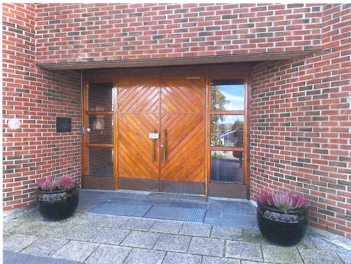
Inngangsparti Nanset kirke, med nyrestaurert inngangsdør
