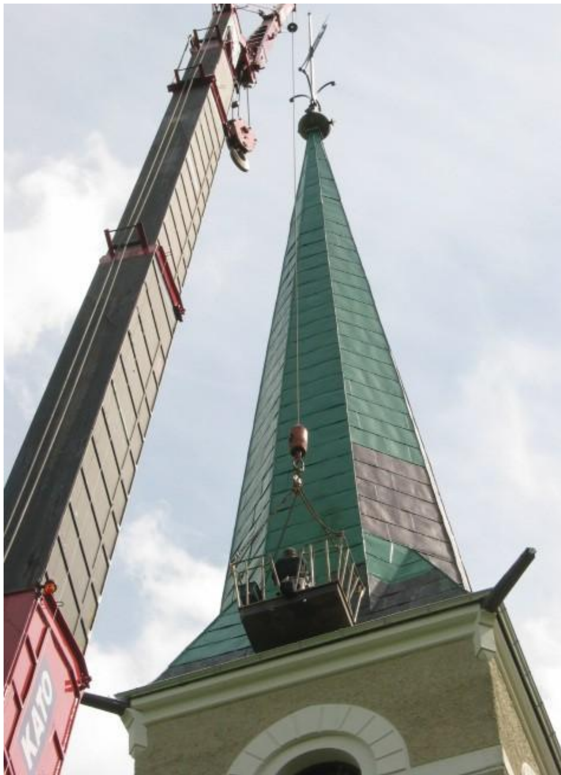
Restaureringen av tårnet på Sjøstad kirke sommeren 2004
