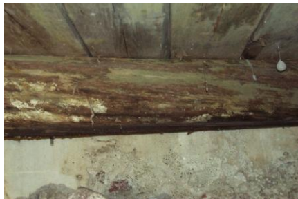
Bjelkelaget under kirkegulvet har betydelige råteskader. Jfr. under-søkelse fra Myco-team. Pris kr 7 132.-
