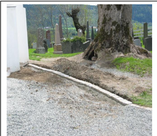
Alle grusgangene og kantsteinene er slutført
