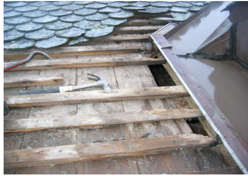
betydelige råteskader ble avdekket
