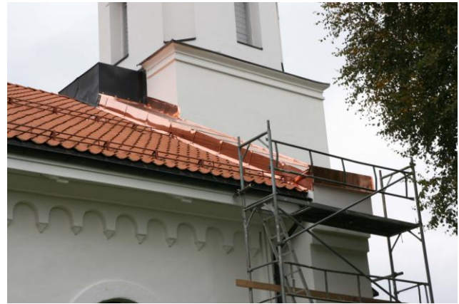
Det ble montert nye mønepanner.
