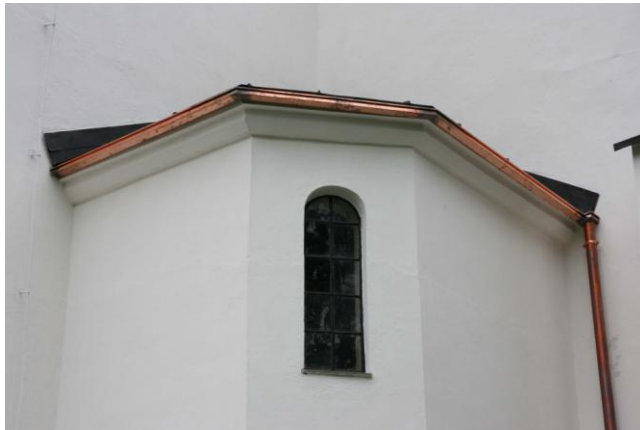
Nye takrenner skal hindre kobberavrenning.
