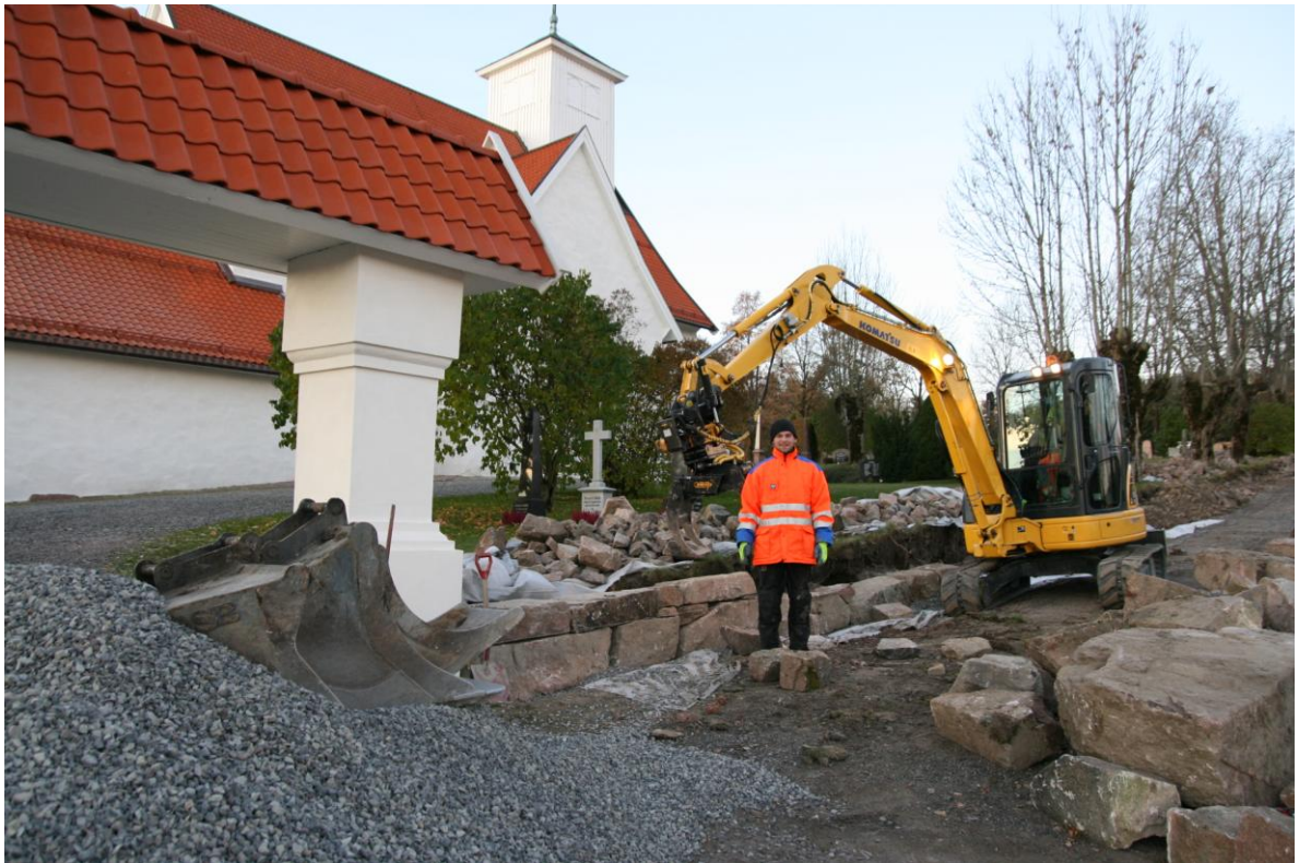
Det gamle steingjerdet nord for kirkegården var falleferdig. Anleggsgartnermester Kent Åsen har fagmessig gjenreist den gamle muren.
