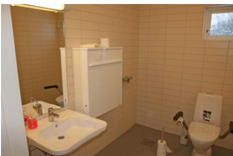
Nytt hc/wc i tilbygget
