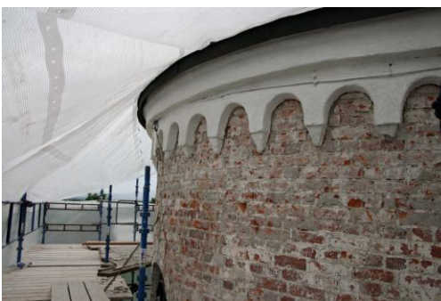
Korbuen er bygget opp av murstein
