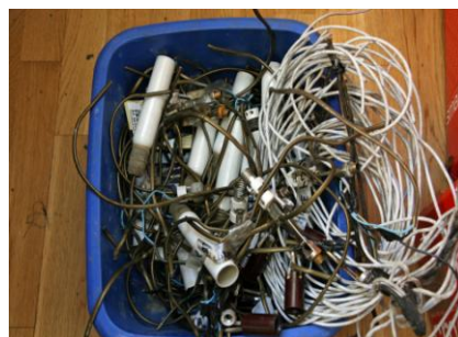
De gamle elektriske ledningene hadde for lengst gjort jobben sin
