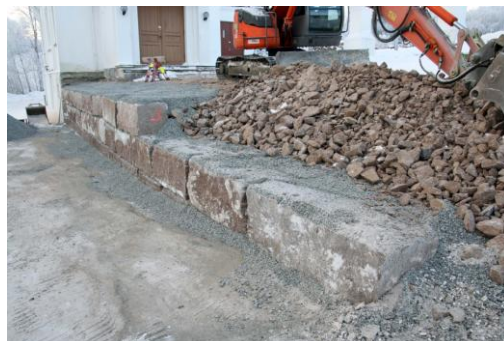
S.O.Transport v/Sveinung Opsahl laget en ny og god forstøtningsmur i Røyken granitt.
