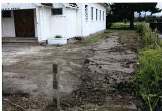
Sommeren 2009 var turen kommet til den gamle vannledningen til Gullaug kirke. Vi stod selv for grøftegravingen mens rørlegger Dammen skiftet vannledningen. El-anlegget fikk ny jording.
