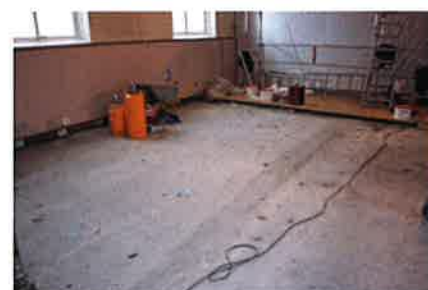
Gulvet er støpt og flisleggingen kan begynne.
