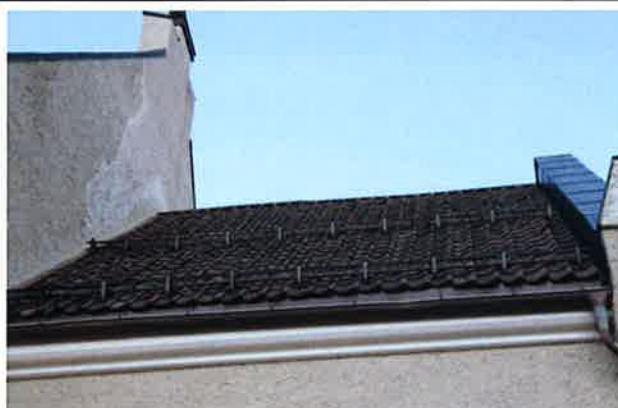
Nye snøfangere montert på hver side av Buskerud Blikk
