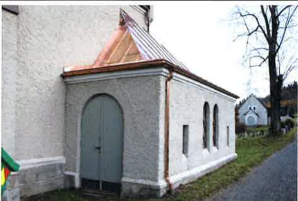
Kobbertekkingen, takrenner og nedløp er fagmessig pent og godt utført
