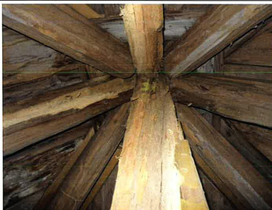
Bilde 09 Råte og insektskader fjernet.
