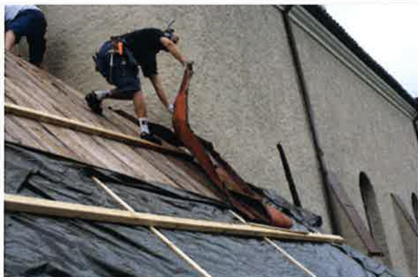
De gamle jernplatene rives av
