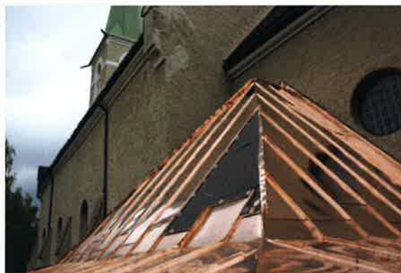
Takpapp og så kobberplater
