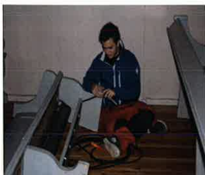
Montering av benkvarmere
