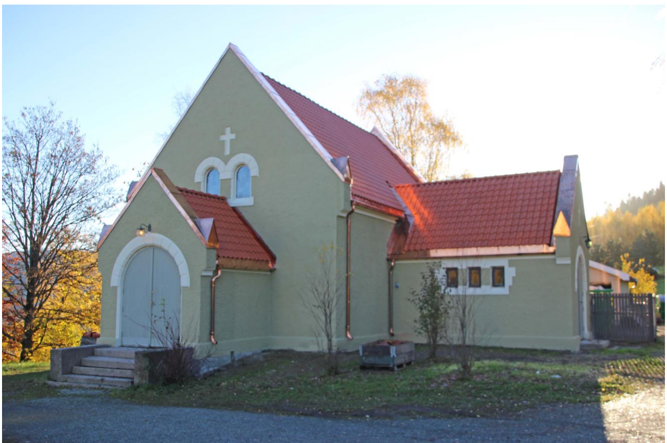
Sjåstad kapell restaurert ferdig utvendig. Nye dører, rullestolinnegang og vinduer gjenstår
