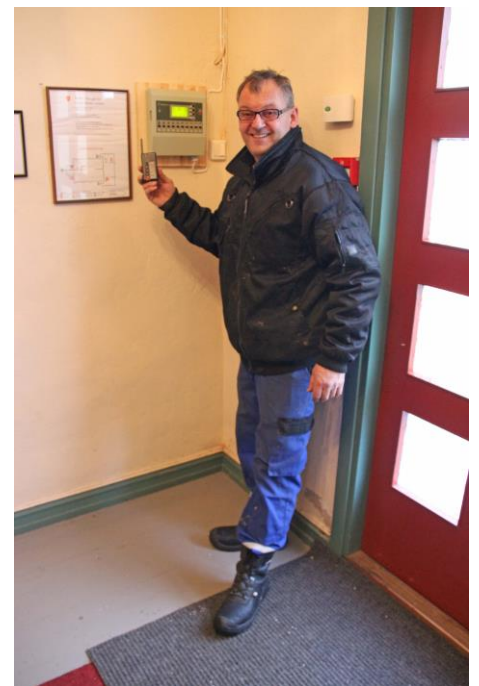
Fjernstyring av ringeanlegget i Sjøstad kirke
