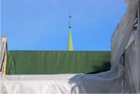
Stilas og presenninger er montert
