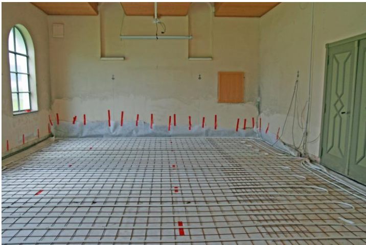
Vannrør og armering montert
