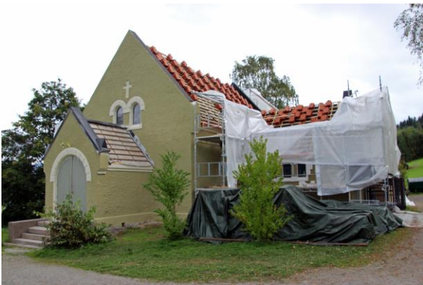
Taksteinen er heist på plass
