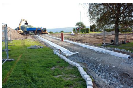
Nytt veianlegg med kantstein
