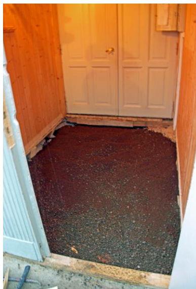
Nytt gulv m/varmekabel
