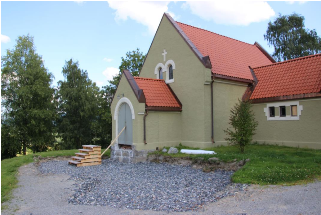
Sjåstad kapell restaurert i fjor. Ny trapp, med rullestolinnngang på plass i år. Prosjektering Castor Kompetanse a.s.
