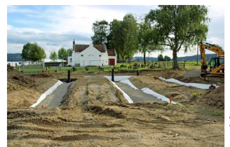
Grøfting og fjerning av leirmasser
