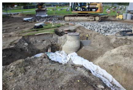
Drenering av kistegravfelt
