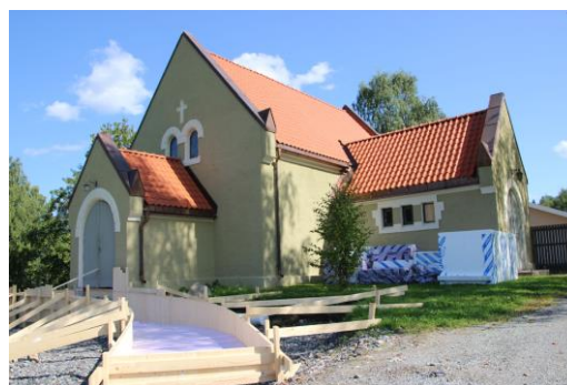
Ny rullestolinnngang m/varmekabel støpes
