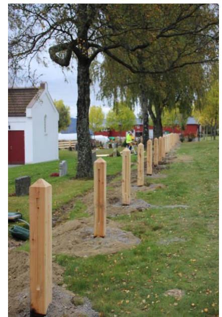
Svein Roar Andersen entreprenør a.s satte opp gjerdet i samarbeid med kirketjenerne
