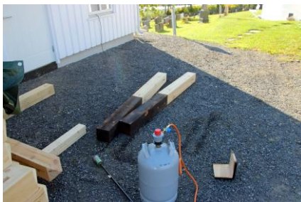
Impregnering på den gamle metoden: Brenning av furustolper for å trekke fram malmen .
