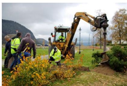
Lier EI- entreprenør ble leid inn for å bore stolpehullene
