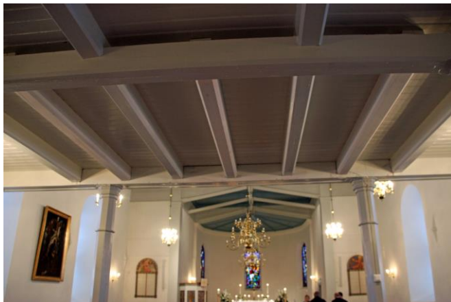
Forsterkninger under galleriet i påvente av nytt orgel
