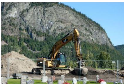
Anleggsarbeidet er i gang
