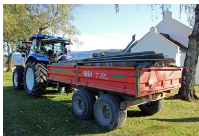
Demontering av det gamle gjerdet
