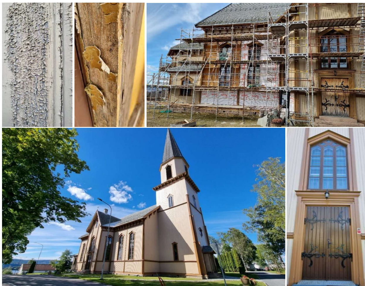
Fet kirke, rehabilitering av fasadene våren 2022
