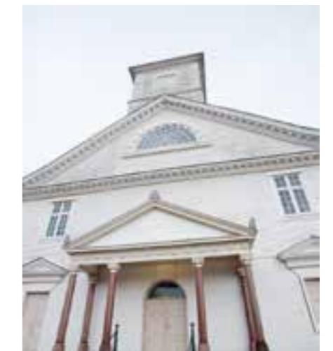
Fra kirkens framside. Det er lagt ny, midlertidig kledning i front i påvente av at arbeidene skal bli fullført.
