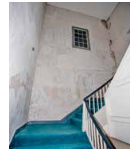
I trapperommet er veggene delvis pusset.
