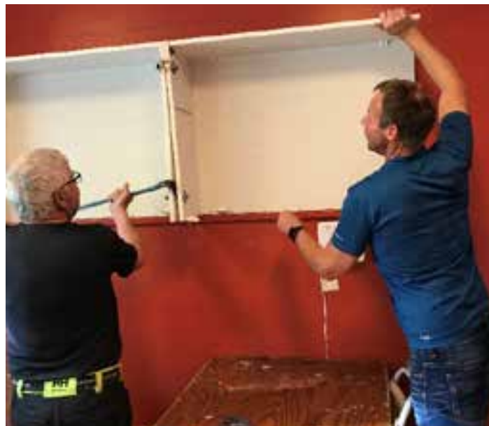
Martin Nomedal og Helge Hogganvik demonterer det gamle kjøkkenet.
