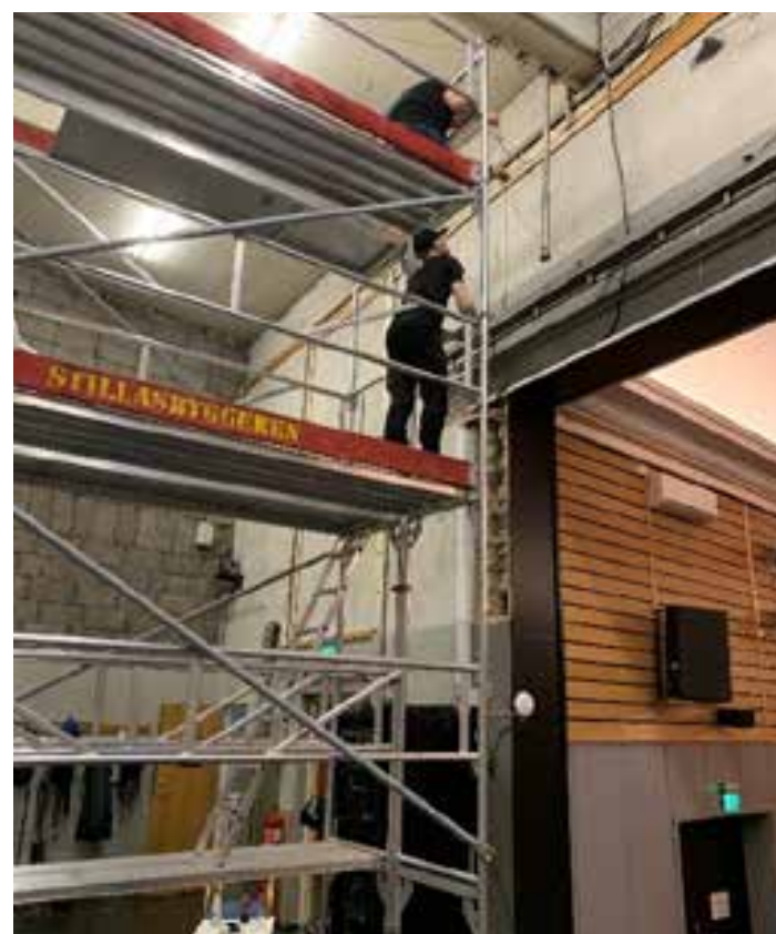
Tore Byberg og Øyvind K. Lund fjerner gammelt utstyr over scenen.
