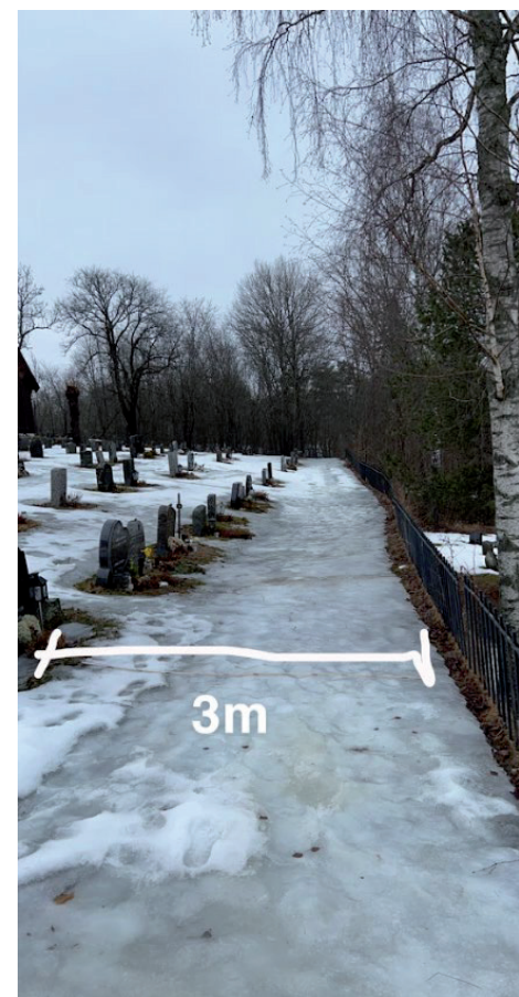
På baksiden og under metallgjerdet til høyre, mot øst, er den aktuelle muren. Den ble trolig bygget i forbindelse med en utvidelse av kirkegården i 1856–7.
