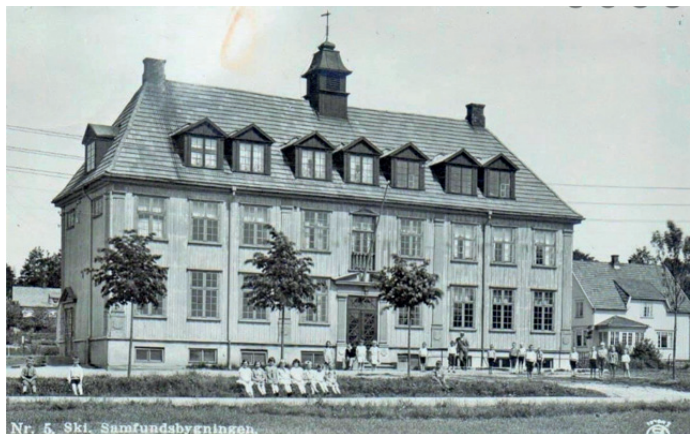
Samfunnsbygningen ble raskt Skis storstue og var i bruk døgnet rundt.
