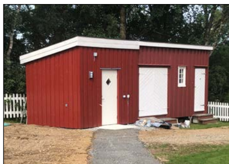
Det nye sanitærbygget ved Ingdalen kirke.
