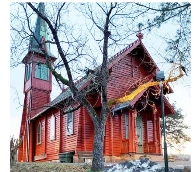
Vakre Ormøy kirke er rehabilitert og reddet fra alvorlig råteangrep.
