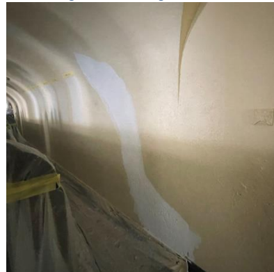
Bilde 3 endring 3. Puss på galleriet utbedret
