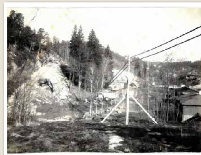
Her bygger de Olaves Hvervensvei og telefonsentralen ved Asperud i april 1981.
