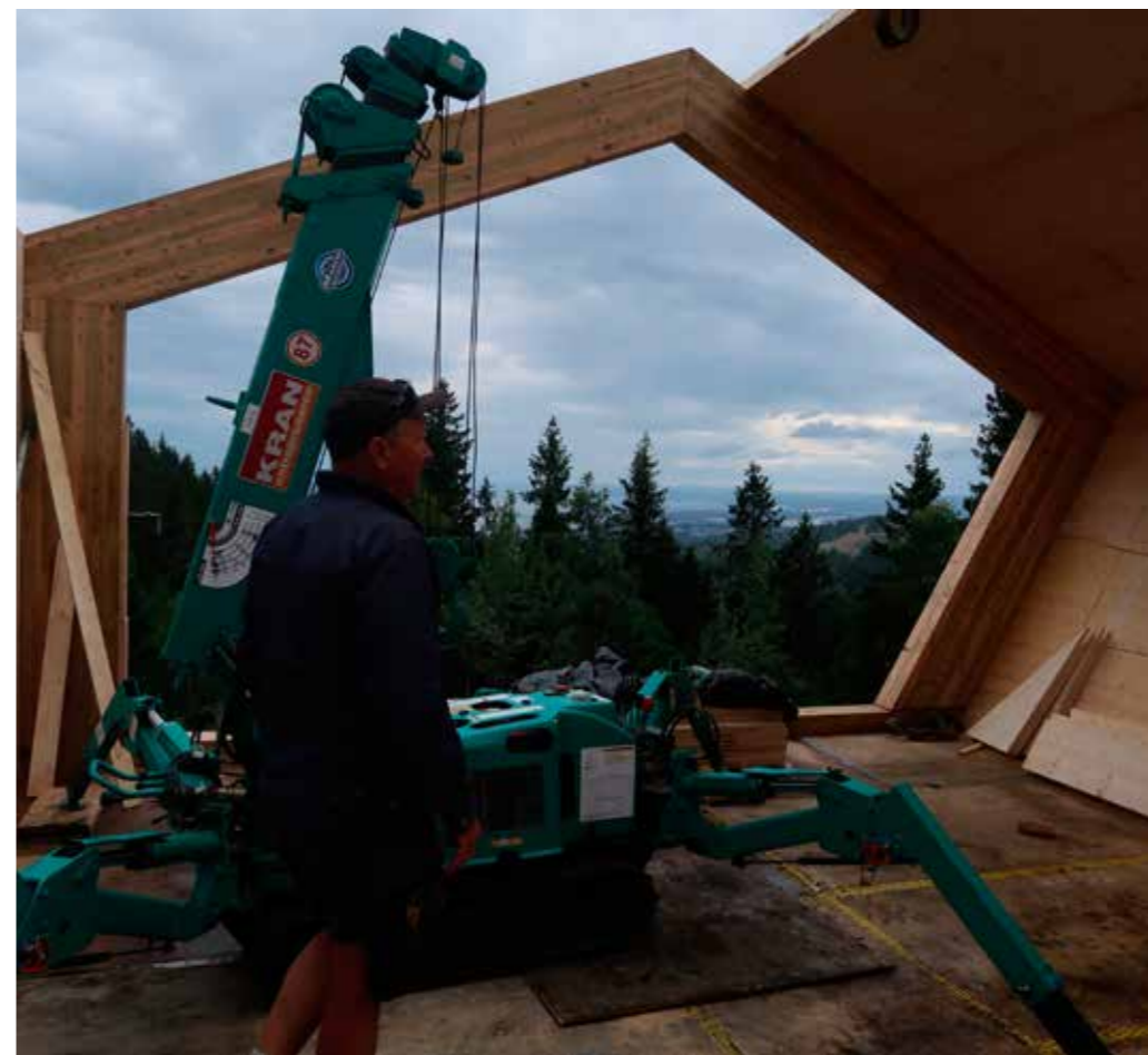
Fuglemyrhytta på Vettakollen under bygging, tegnet av Snøhetta-arkitekter. Stort foto på forrige og denne siden av Olav Ringdal.
