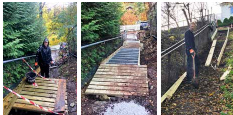
NYE TRAPPER: Sverre E. Forsstrøm i full sving med trappearbeidet (bildet t.v.). Trapper og platåer ned mot Røahagan (bildet i midten). Sverre E. Forsstrøm forbereder siste etappe mot Røaknekk (bildet t.h.).
