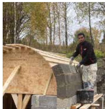
Bygging av jordkjeller i Voksenenga.
