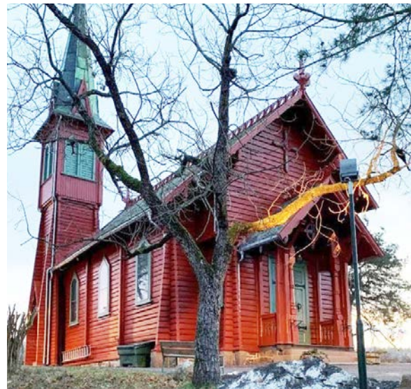
Vakre Ormøy kirke er rehabilitert og reddet fra alvorlig råteangrep.
