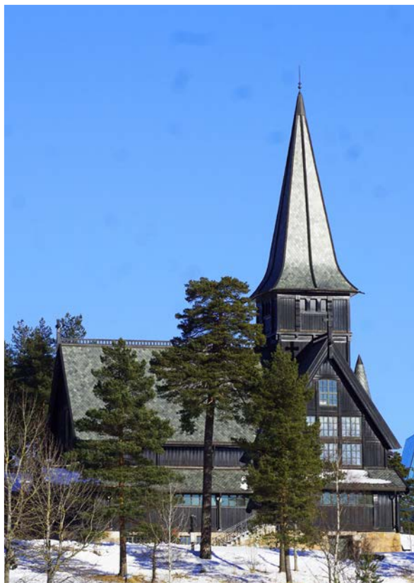
Store råteskader er utbedret på Holmenkollen kapell.
