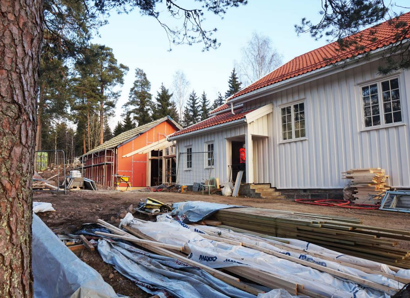
Maridalen kirke har fått et diskré og etterlengtet tilbygg på baksiden.
