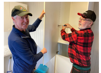
John Olav Skaug (t.v.) og Arnfinn Degvold i gang med skapmontering. Foto: Karsten Nyborg
