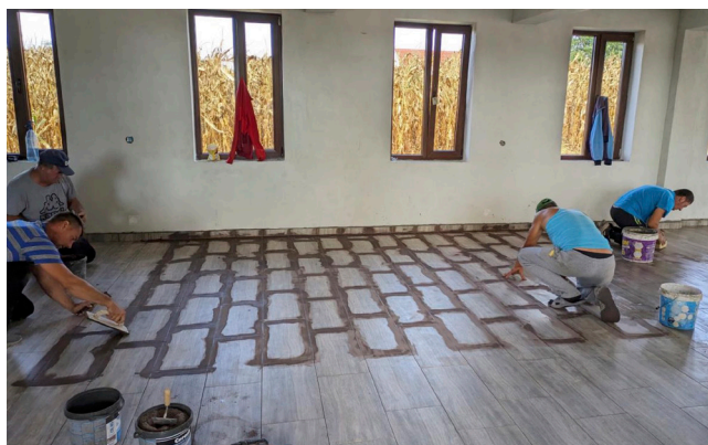
Huset innvendig tar form - 2023
