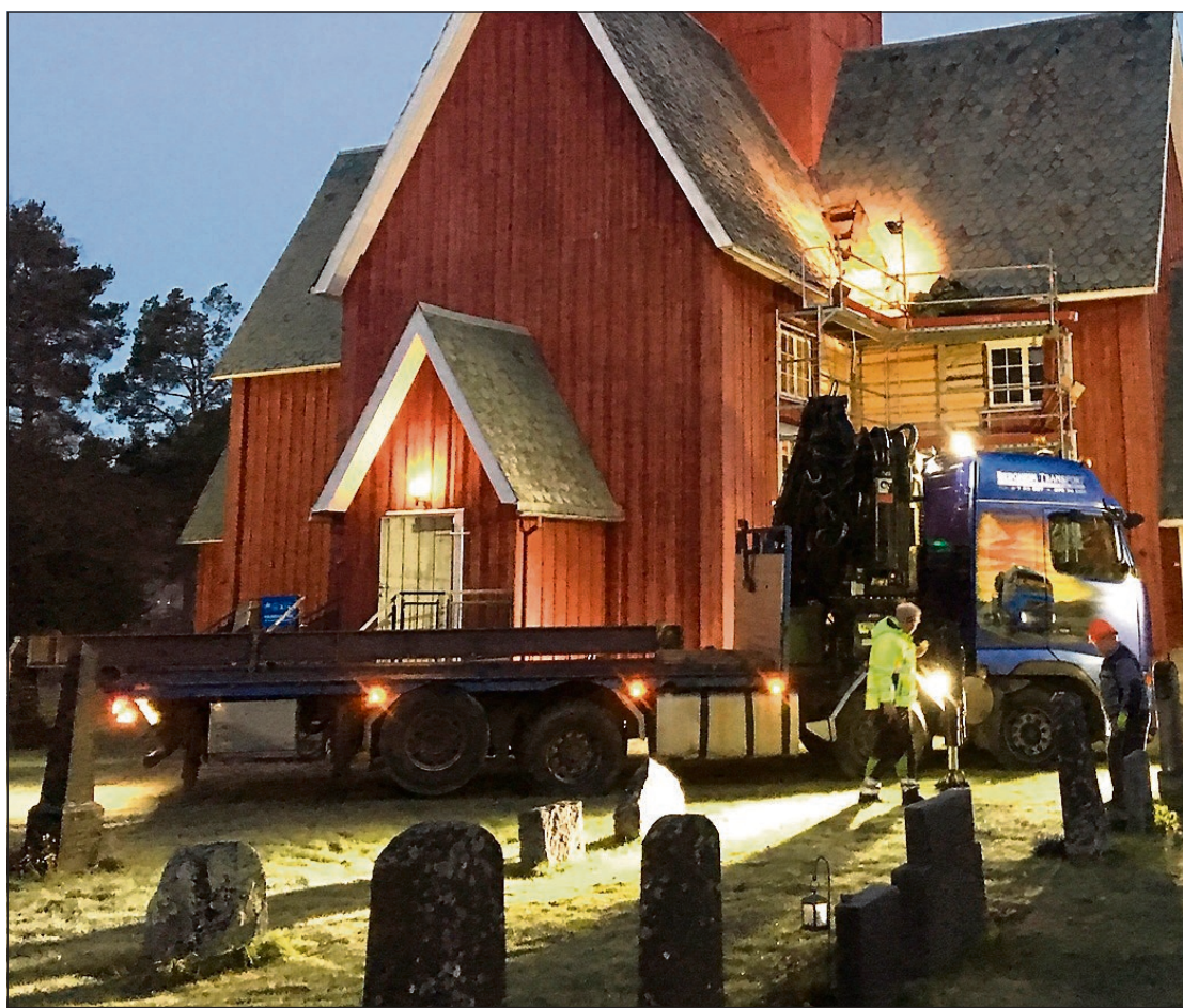
BÆREBJELKER: To jerndragere må opp og inn under kirketårnet.
