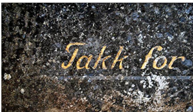
Innlegg med gull og lakk taper seg og krever oppussing
