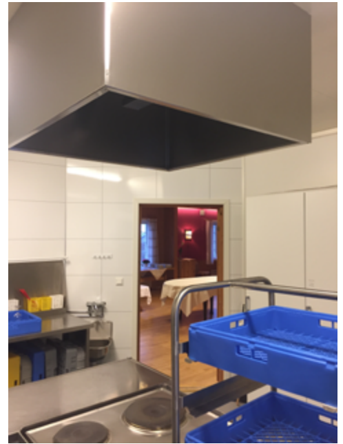
Ny og forbedret ventilasjon på kjøkkenet
